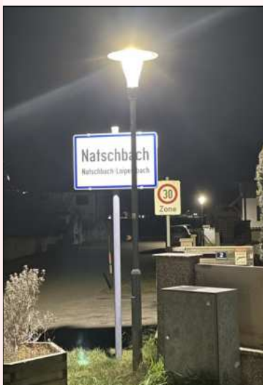
unten: LED Straßenbeleuchtung im Ortsgebiet
